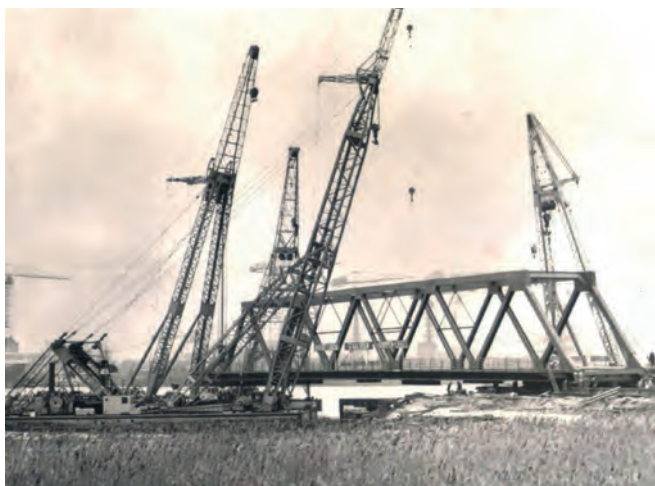
Hollandia bouwde de vaste brug in de Stormpolder
