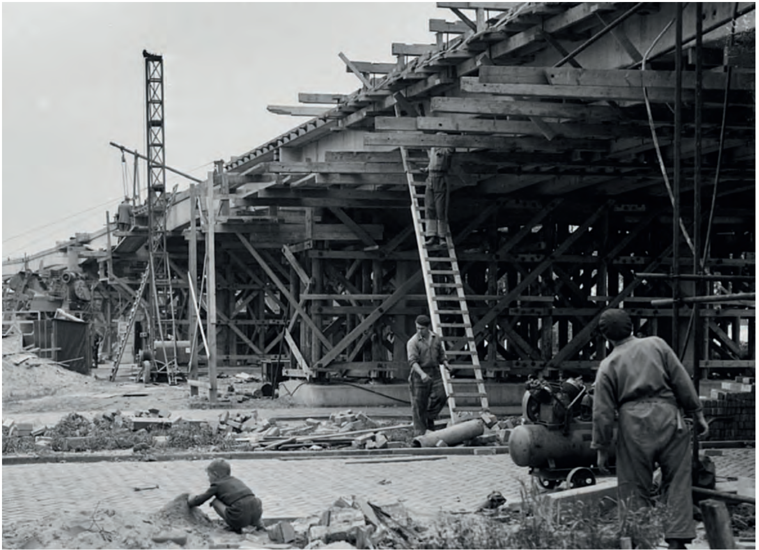
Bouwwerkzaamheden aan viaduct ter hoogte van de Noorderstraat
