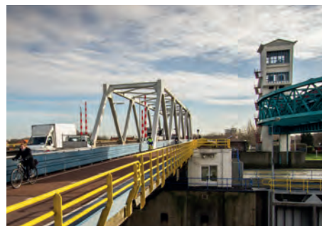
9 Algerbrug sluit maximaal 6 weken voor autoverkeer
