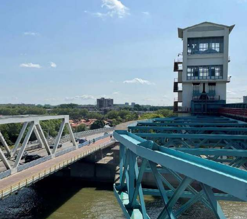
afbeelding 10. De afhankelijkheid van de brug maakt de verbindingen met de regio kwetsbaar.
